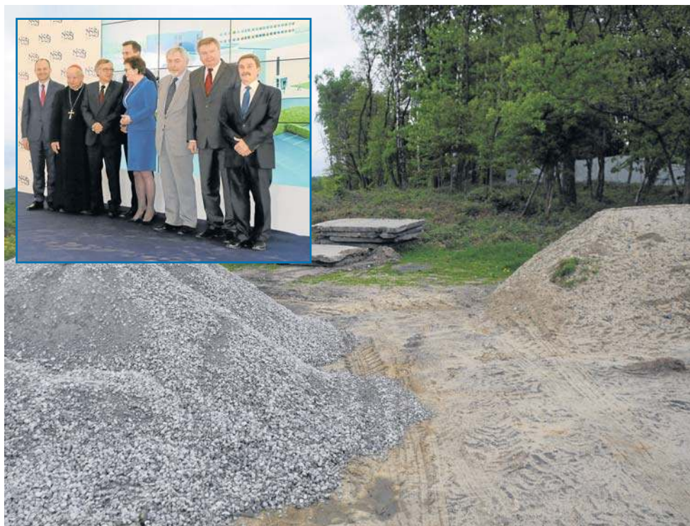
► Tydzień temu w Prokocimiu stał piękny namiot z podłogą, a politycy uroczystości rozpoczęli budowę szpitala (na małym zdjęciu). Dziś żadnych prac tam nie widać. Ani sprzętu, ani robotników
