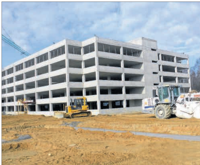
Gotowa jest już konstrukcja parkingu przeznaczonego dla 700 aut
